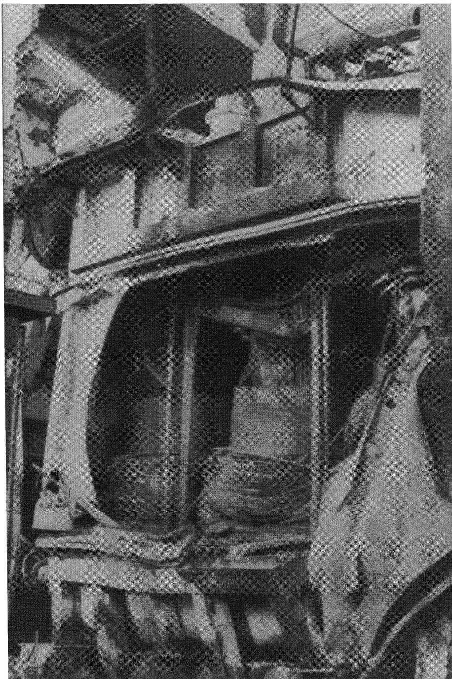
Fig. 9. – Centrale di Galleto: trasformatore da 43 MVA.
